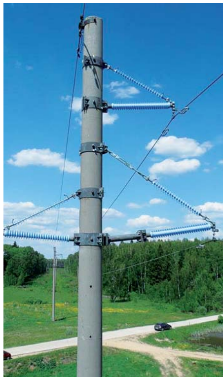
Рис. 3. Изолирующие траверсы на ВЛ 110 кВ «Суходрев» — «Спутник» филиала «МРСК Центра и Приволжья» «Калугазэнерго»
