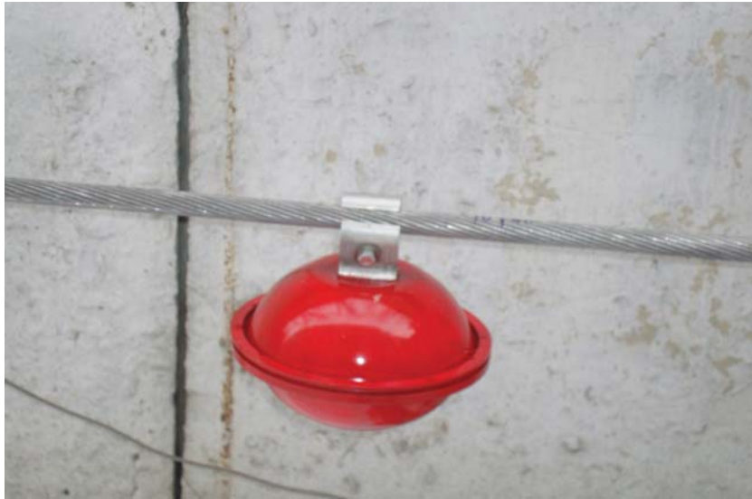
Рис. 4. Внешний вид широкополосного гасителя вибрации.
