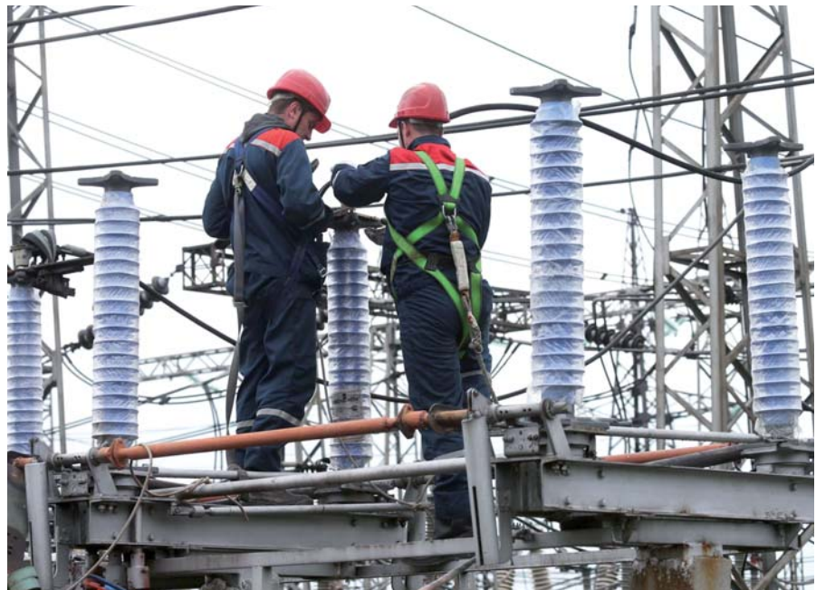
Рис. 4. Монтаж изоляторов типа ОСК на ОРУ ПС
