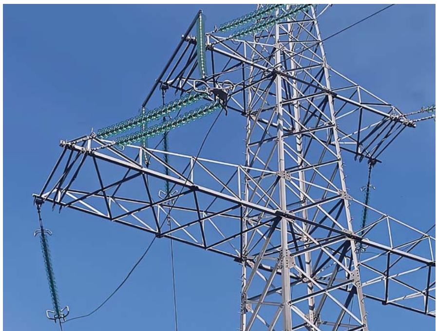
ВЛ 220 кВ Туран — Туманная, построенная с применением изолирующих подвесок нового поколения
