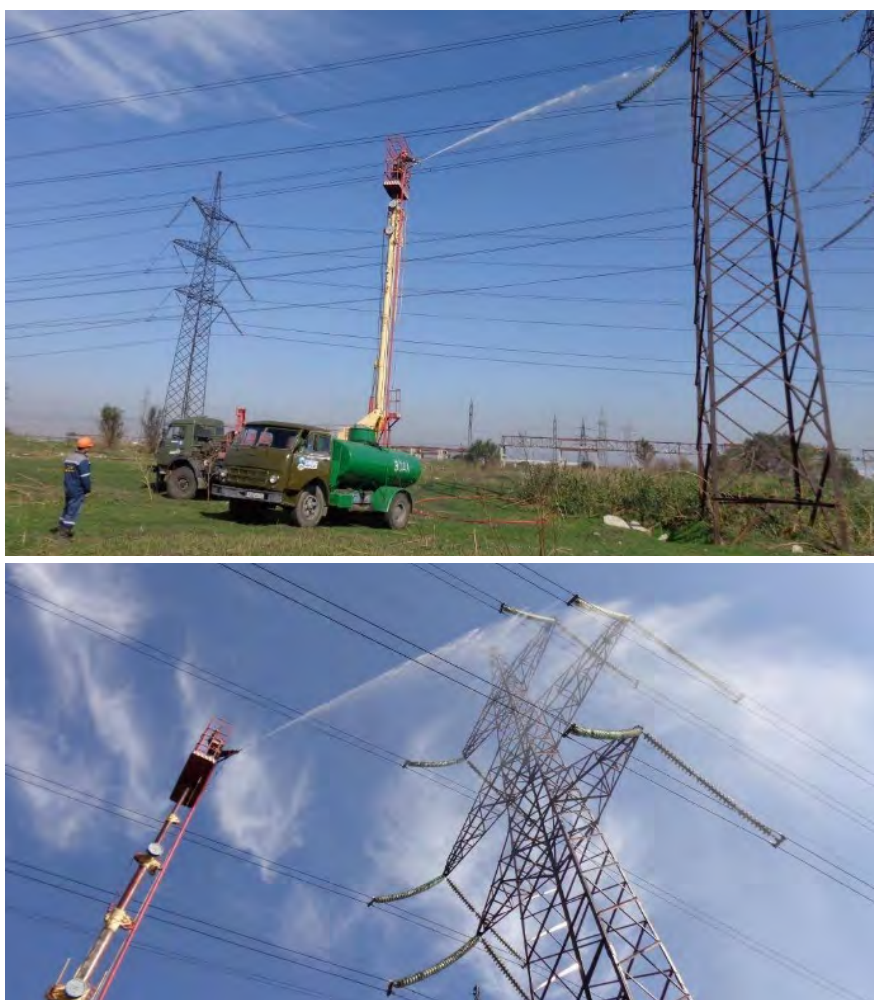
Рис. 5. Чистки и мойки гирлянд изоляторов с использованием специализированных машин
