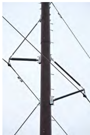
Рис. 1. Опора ВЛ 110 кВ
