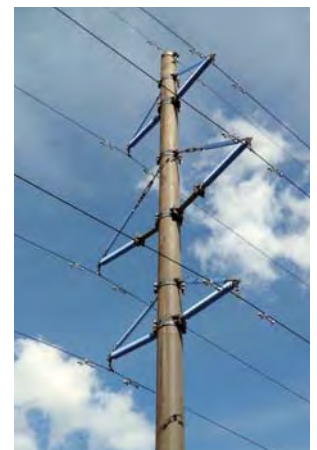
Рис. 3. Эффективность изолирующих траверс
